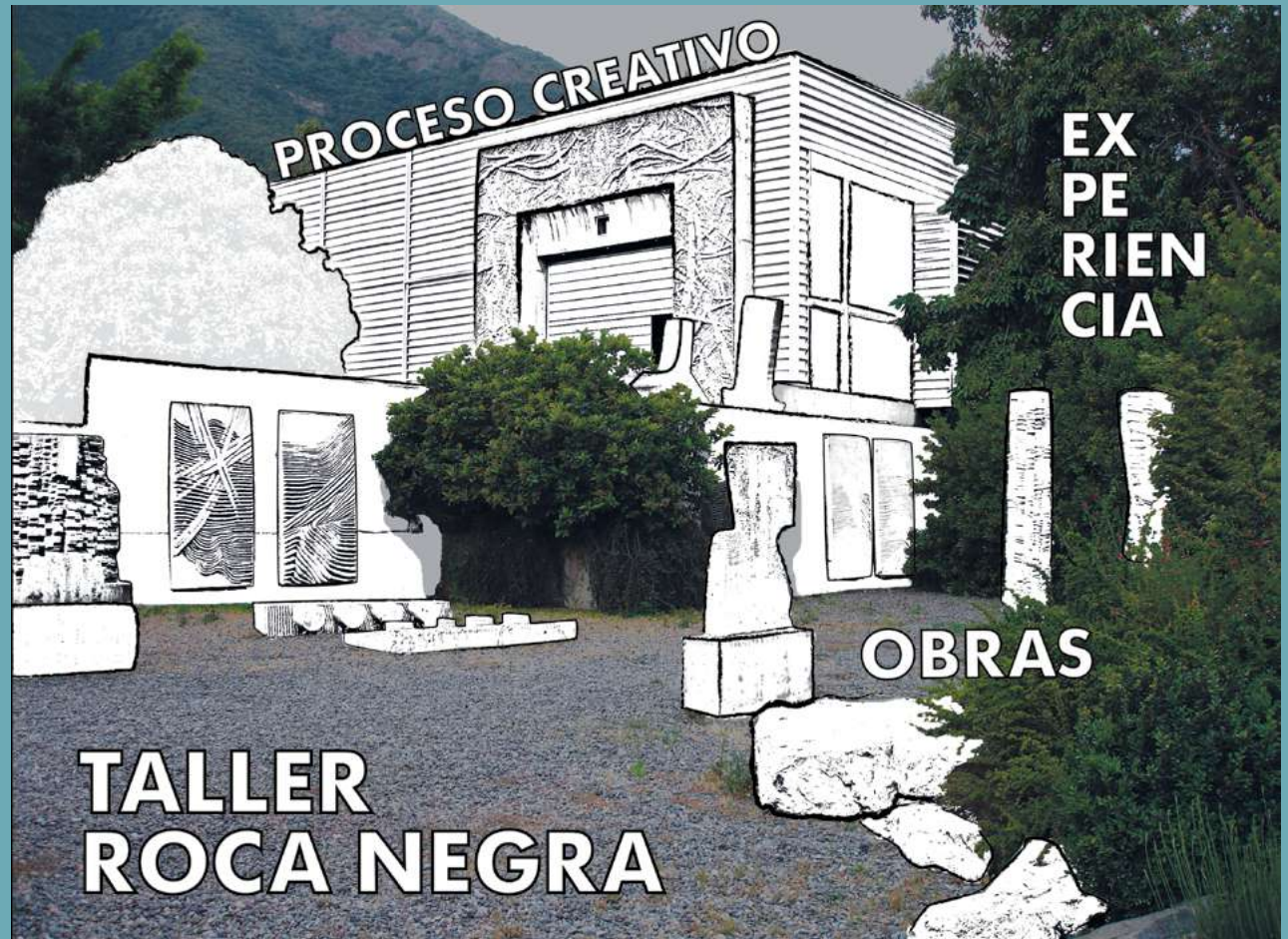
Taller Roca Negra. La obra, San José de Maipo.
